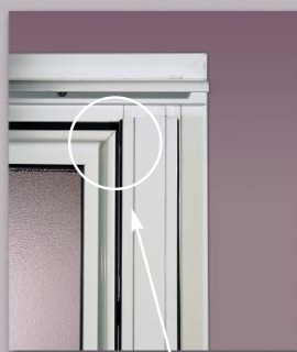
Apertura de la ventana (1): separación de la aleta exterior.
