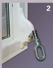
Apertura de la ventana (1): separación de la aleta exterior.
